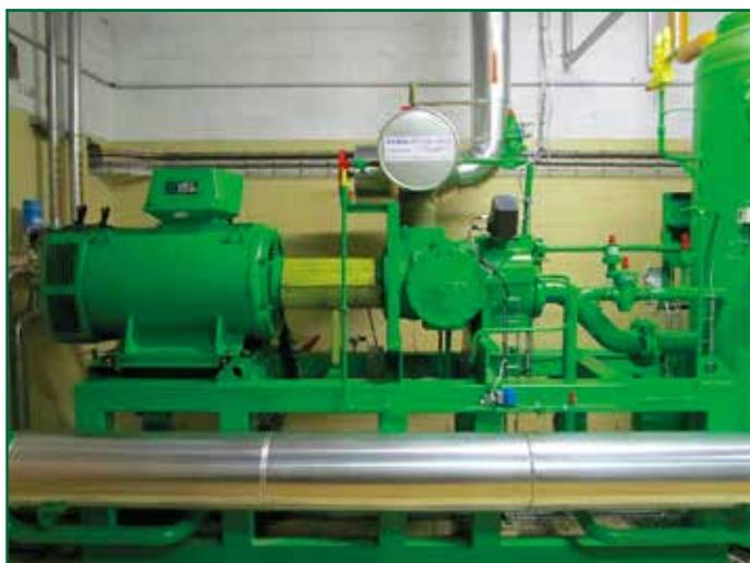
**Figura 1 – Compressore monovite Vilter azionato da un motore sincrono a magnete permanente Dyneo® PLSRPM.**
