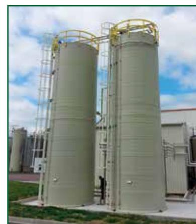
**Figura 4 - Serbatoio di accumulo di acqua calda.**
