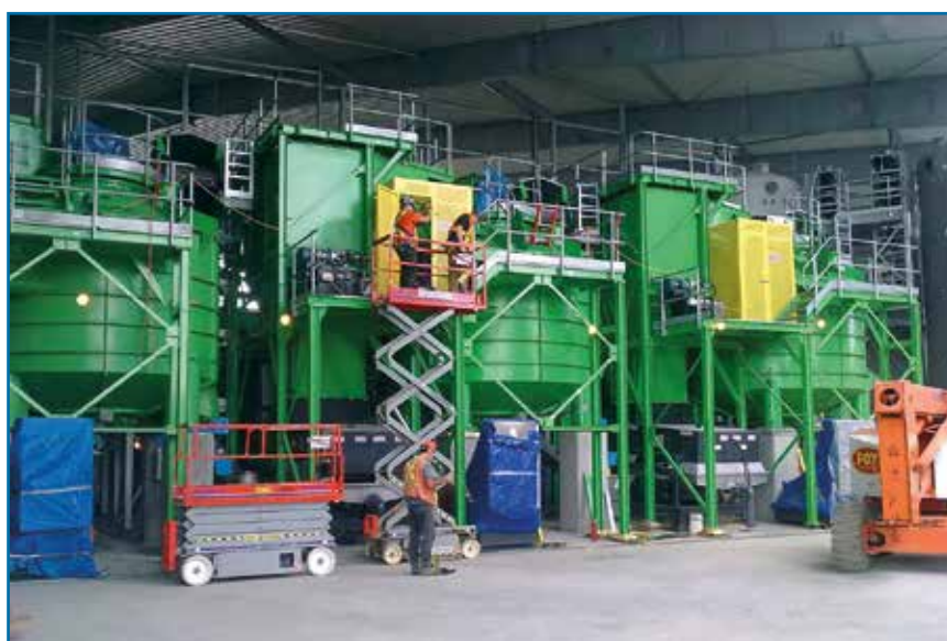
Figura 4 – Impianto di Disco Road (Toronto, Canada), fase di montaggio.
