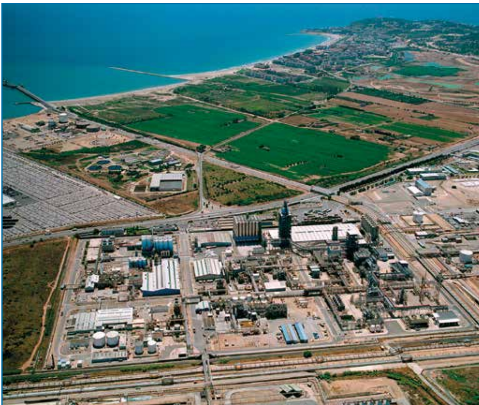
Figura 1 – Impianto di Tarragona.
