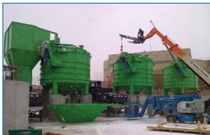
Figura 3 – Fase di montaggio dell'impianto di Disco Road (Toronto, Canada).
