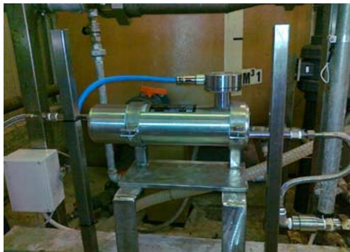
**Figura 2 - Il misuratore massico Coriolis installato presso il depuratore di Como.**
