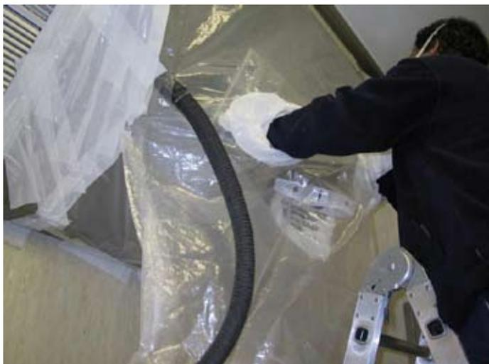
**Figura 5 - Particolare della bonifica di una condotta.**
